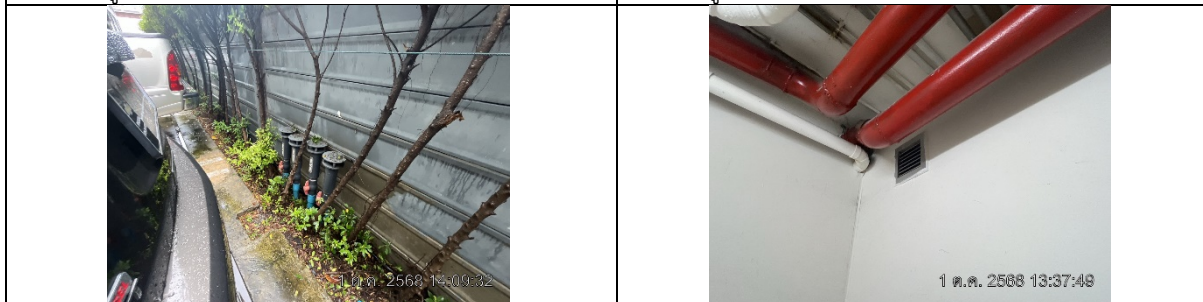
รูปที่ ผ7.14 ท่อระบายก๊าซมีเทน
